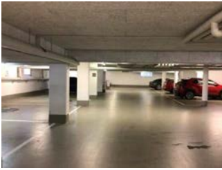
Weg in Tiefgarage zum Eingang
